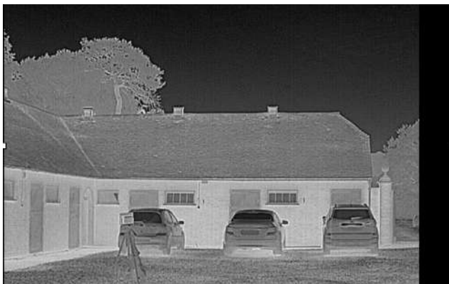
Survey 3 - 02/07/26 - Thermal camera
