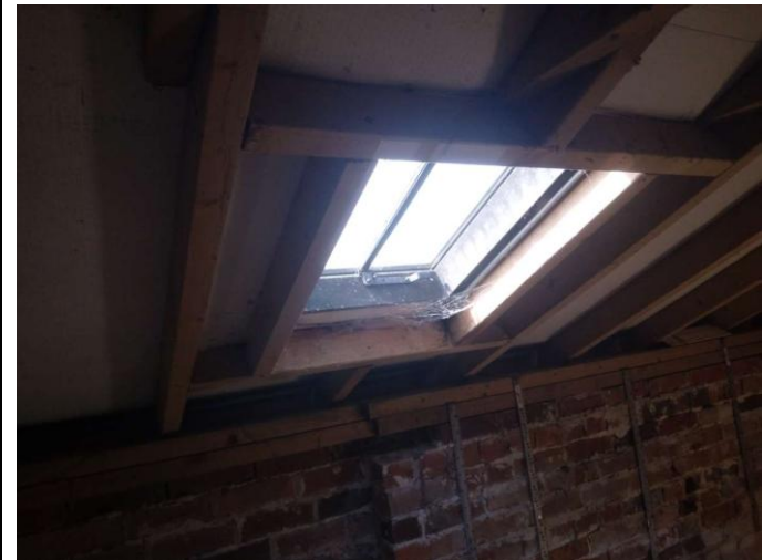
B2 – Void skylight
