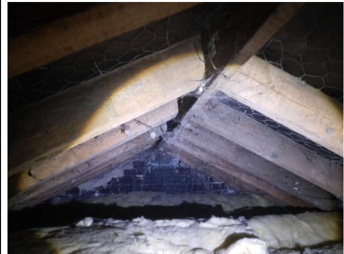
B1 - Loft void Lv2
