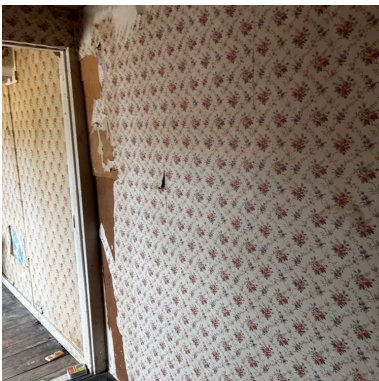
IMG0016 – Hardboard partiton
