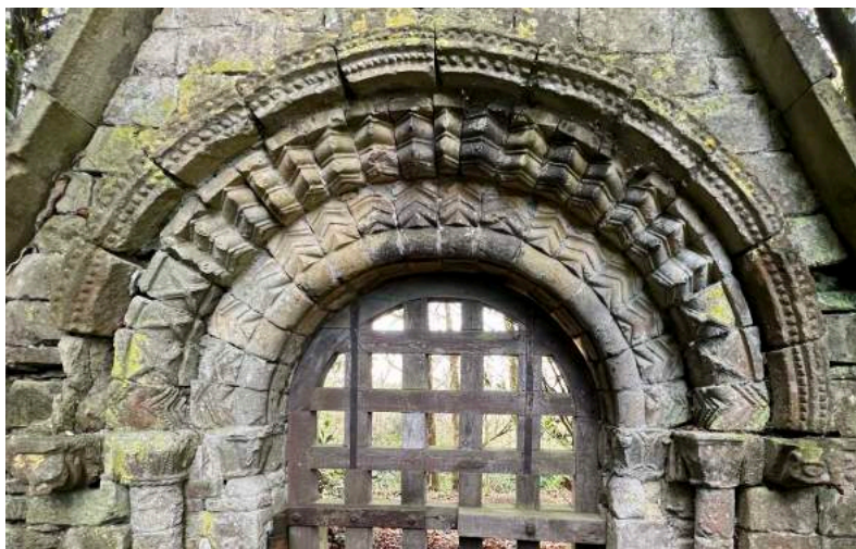
Figure 232 Detail of archivolt.
