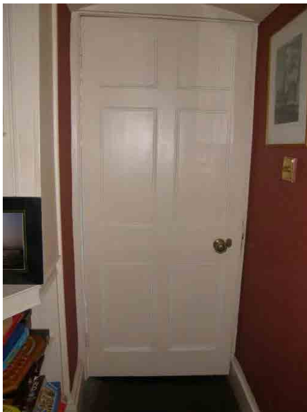
Fig. 11 6-panel door to hall (D5)
