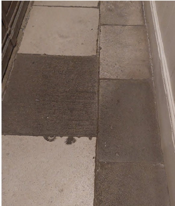
Photo 1 Long passage B29
